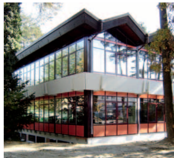
Haus des Buches in Waldkraiburg mit neuer Fassade
